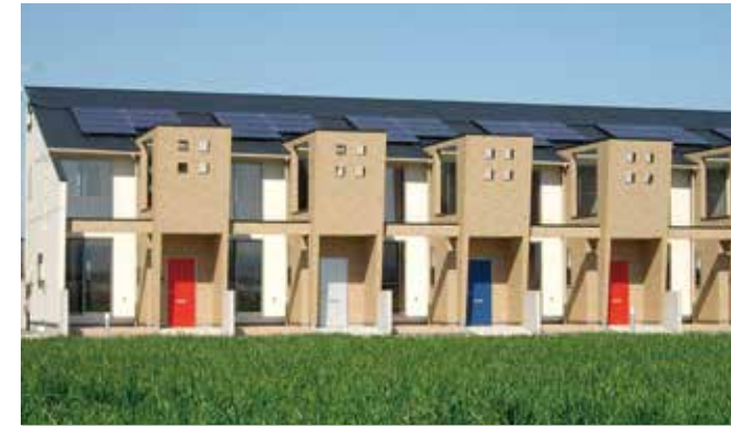
埼玉県 7.77 kWシステム
