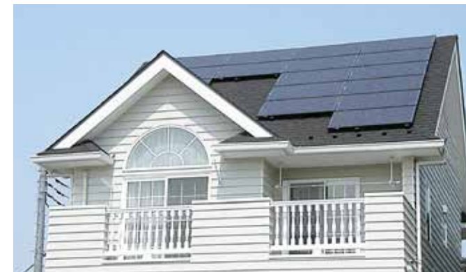
埼玉県 2.96 kWシステム
