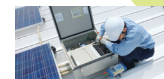
解放電圧測定の様子
