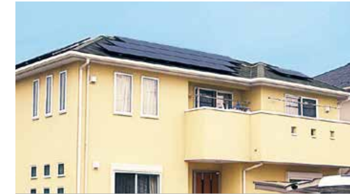
栃木県 3.42 kWシステム
