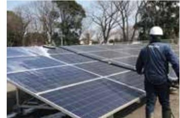
■ 稼働7年目に太陽電池パネルの洗浄を実施した結果、10%以上の発電効率の回復を確認しました
