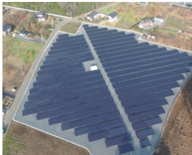
■ 水戸市小林町太陽光発電所
