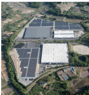
■ LIXIL須賀川SOLAR POWER
