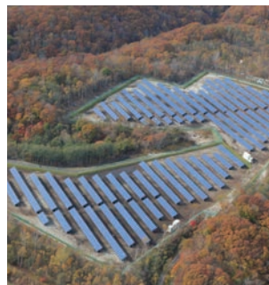
■ 苫小牧太陽光発電所
