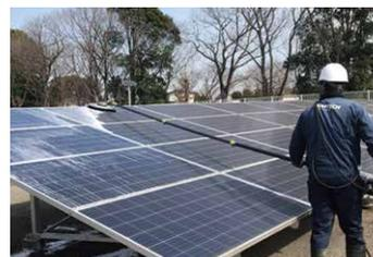
■ 稼働7年目に太陽電池パネルの洗浄を実施した結果、10%以上の発電効率の回復を確認しました
