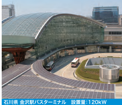
石川県 金沢駅バスターミナル 設置量:120kW
